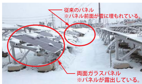
フレームレス両面硝子モジュール 30年、83%の保証
